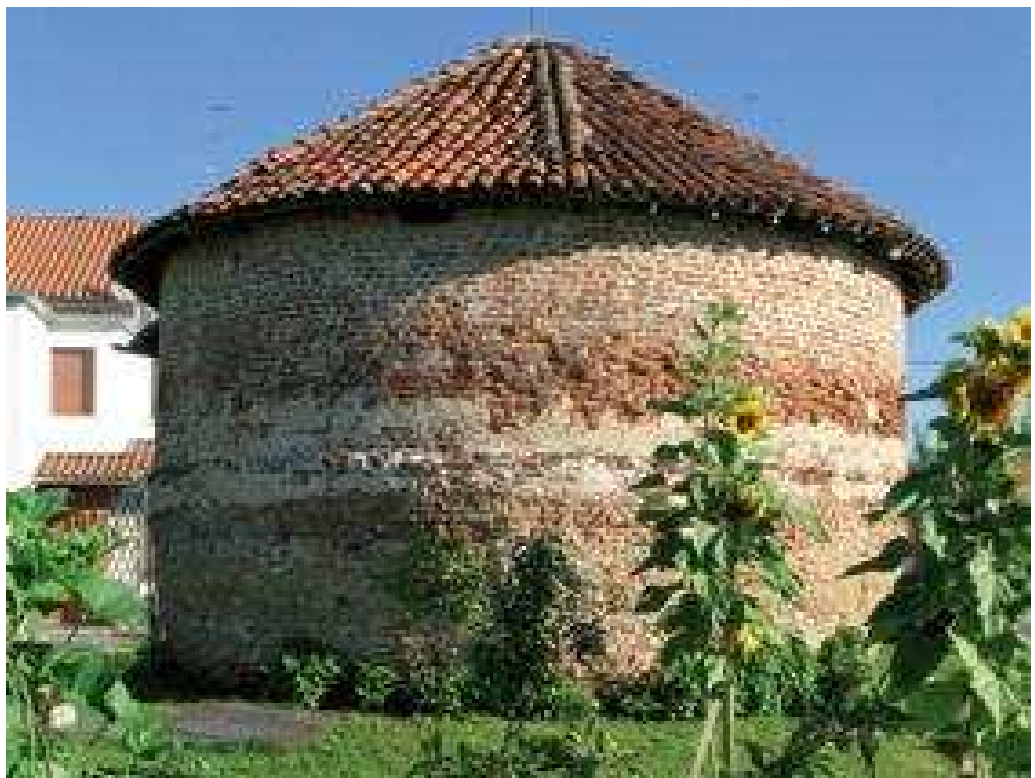
In alto: cortile interno del Castello; in basso: la Ghiacciaia
