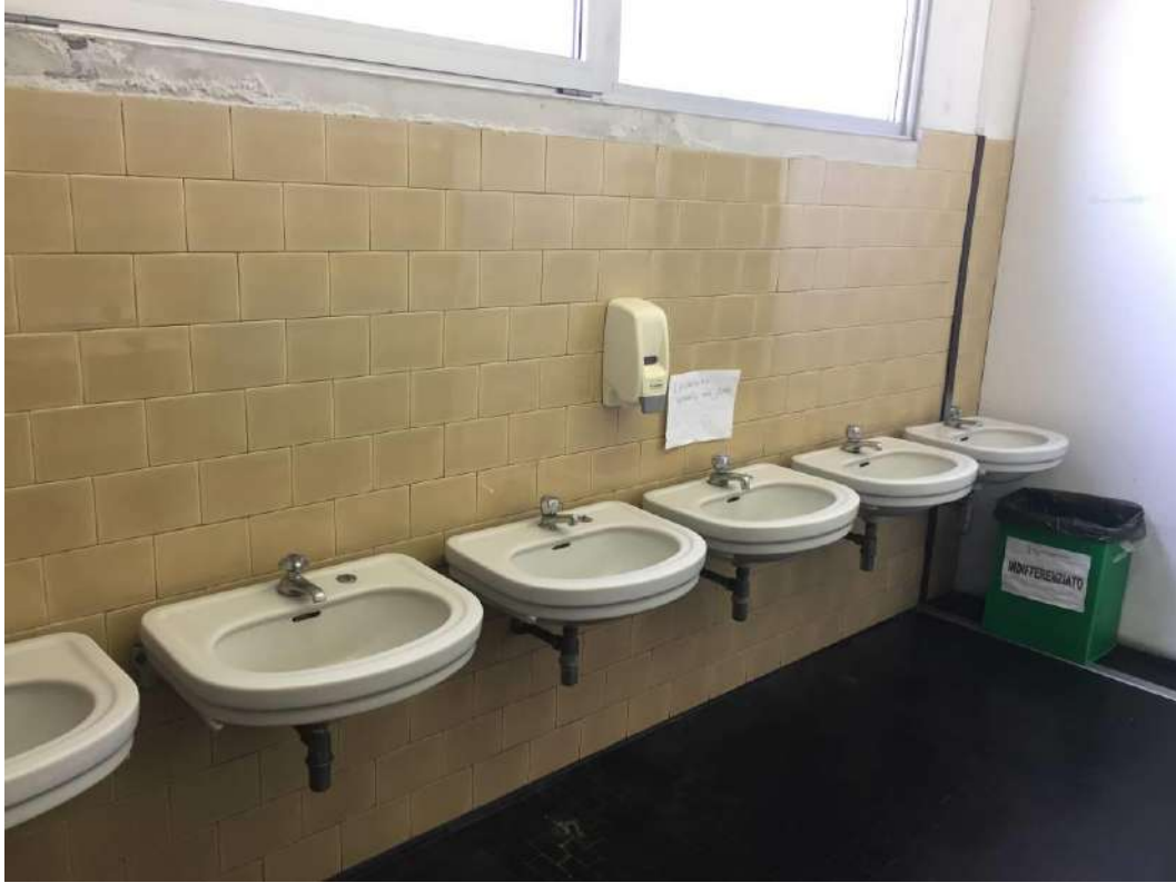
Vista lavabi da sostituire
