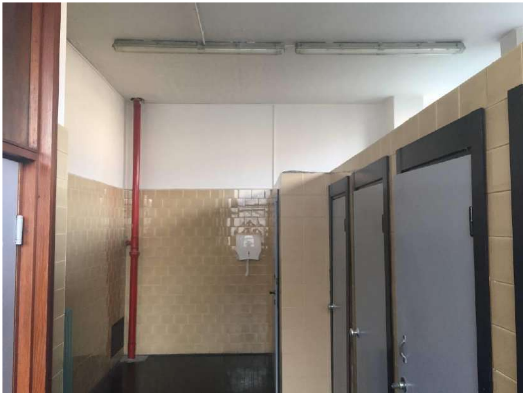
Vista pavimenti e rivestimenti da sostituire
