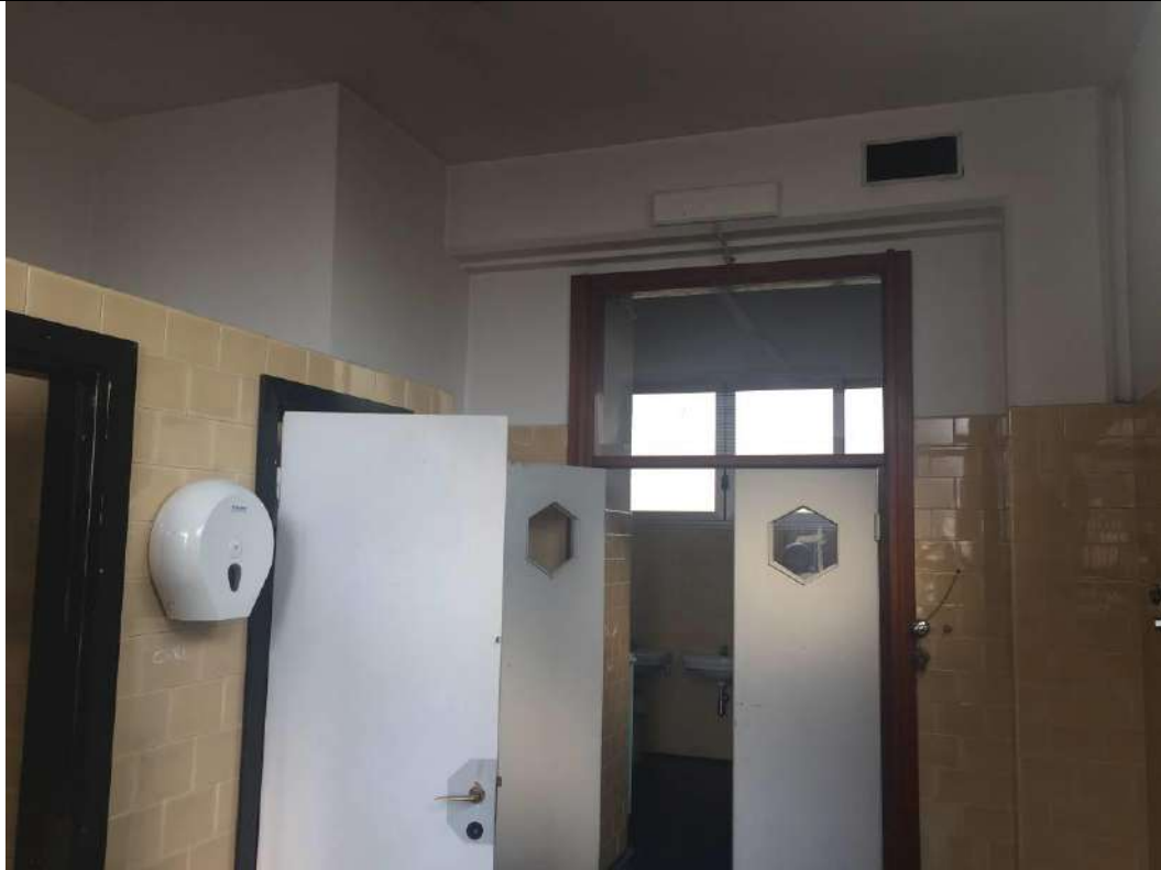
Vista serramenti da sostituire e vecchio canale di aerazione
